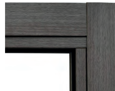
KOLMÉ NAPOJENÍ SVISLÝCH A VODOROVNÝCH ČÁSTÍ ZÁRUBNĚ
