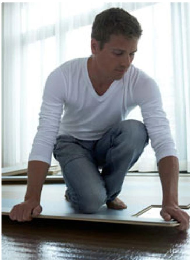
Marmoleum® click lze snadno pokládat. Lamely se v pravém slova smyslu spojují „zakliknutím“. Pokládka se provádí bez lepení, ihned po pokládce můžete podlahu používat. Tato technika pokládky nabízí samozřejmě i další výhody. Marmoleum® click se může znovu rozebrat bez poškození podkladu. Jednotlivé lamely mohou být případně vyměněny, pokud by někdy došlo k poškození.
